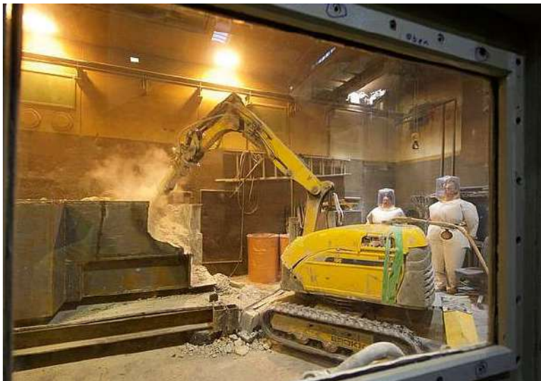
Variabel bestückbarer Mini-Bagger in MAW Zelle KTE
